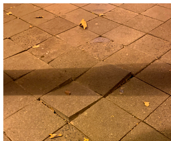
Abbildung 54: Lose und wackelige Fliesen im Lessingtunnel
